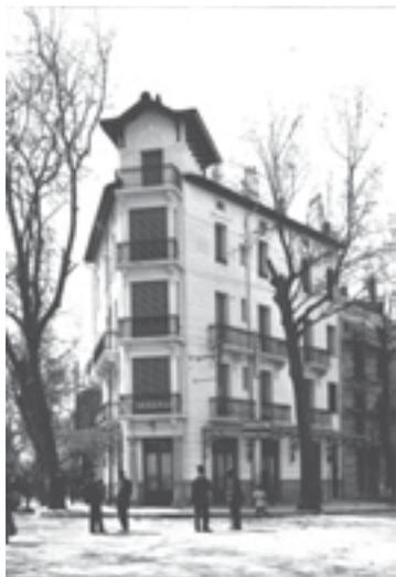
**Planchers, linteaux, balcons, poteaux, bow-window sont en béton armé.**
